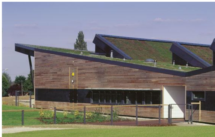
Σχήμα 28: Φυτεμένη στέγη
