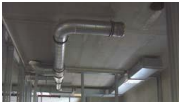
Σχήμα 45: Μηχανικός εξαερισμός
