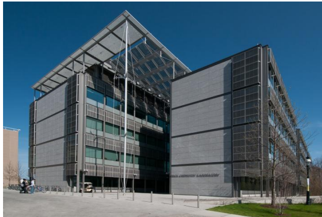
Σχήμα 47: Στέγαστρο φωτοβολταϊκών στο Κτίριο του Spilker Engineering & Applied Sciences, Stanford University
