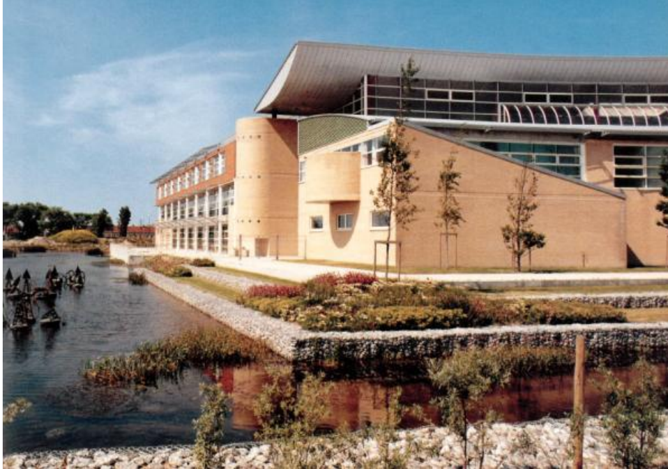
Σχήμα 33: Συγκέντρωση του νερού της βροχής σε συλλεκτήρια περιμετρική λεκάνη
